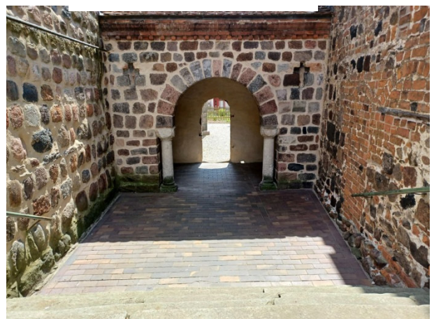
Vom Innenhof des ehemaligen Zisterzienserinnenklosters zum Verbindungsbau zwischen Kirche und ehemaligem Kloster
